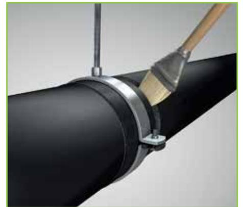
3. อุดรอยต่อชนแบบเป็ยกด้วยกาวและติดตั้งท่อ ArmaFlex FRV ที่ทั้งสองด้านของตัวพุงท่อหุ้มฉนวน
